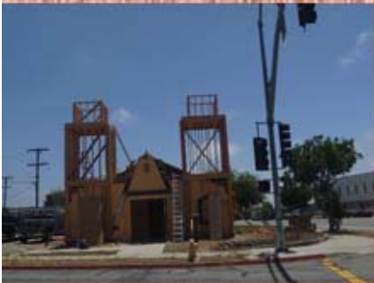
Thánh Thất lúc sửa chữa
